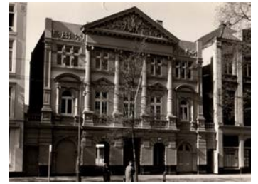
De gevel van de Hollandse Schouwburg Source: Archive of Jan Leupen
