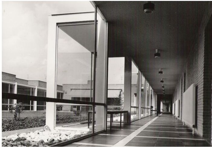
GGD Ringbaan West 227, 1962-1967
