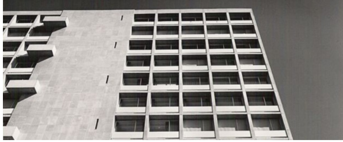
Tjallink Koopmans-gebouw (2) Warandelaan 2 1965-1972
